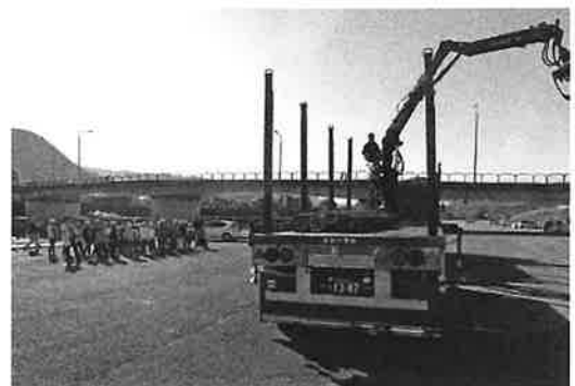
クレーン作業を見学
